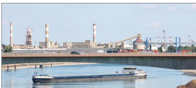
Le Rhin et le canal qui le double, le Grand canal d'Alsace, comptent en tout douze centrales hydroélectriques sur la partie alsacienne du fleuve. Photo L'Alsace
