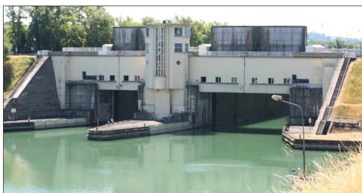
En plus de la centrale, le Grand canal d'Alsace est barré par une écluse monumentale aussi gérée par EDF. Il perd du coup 15,5 mètres de hauteur entre amont et aval. Photo L'Alsace
