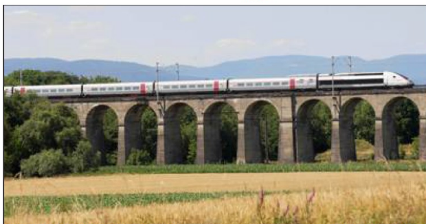
Le grand viaduc de Dannemarie aujourd'hui.
