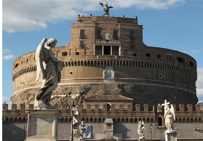
Commencée en 135 et terminée 4 ans plus tard, cette construction fut à l'origine destinée à la sépulture de l'empereur Hadrien et de sa famille. Sa base carrée (84 m de côté) était surmontée d'une partie cylindrique d'environ 20 m de hauteur et se terminait alors par un tumulus coiffé d'une statue de l'empereur et d'un quadrigé de bronze.
